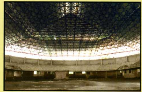
Siliguri Indoor Stadium, Siliguri
